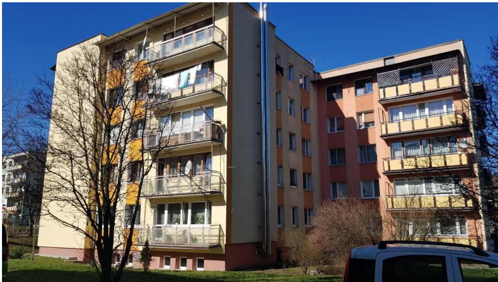
ELEWACJA BUDYNKU OS. 1000-LECIA 27
