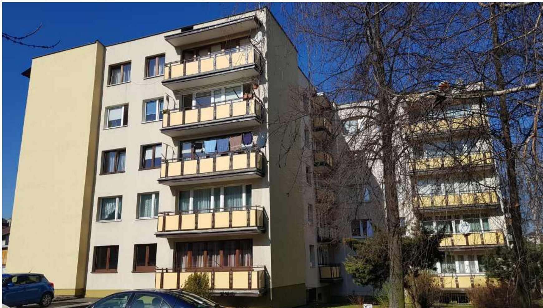
ELEWACJA BUDYNKU OS. 1000-LECIA 29
