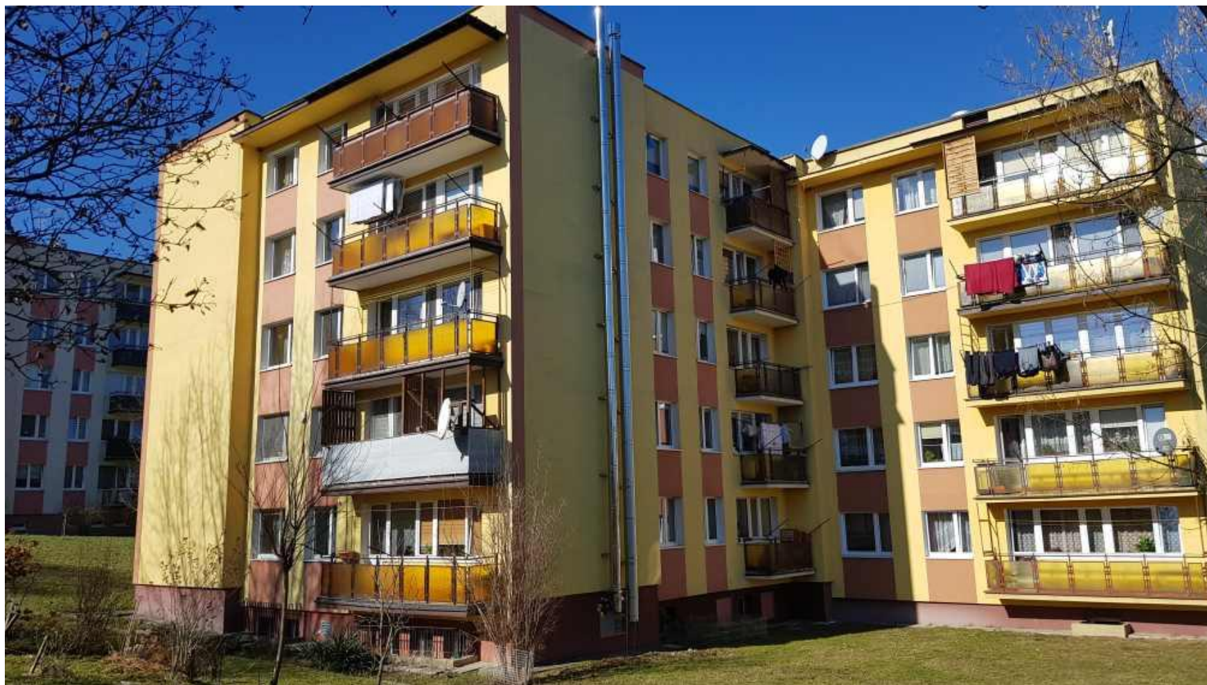
ELEWACJA BUDYNKU OS. 1000-LECIA 33
