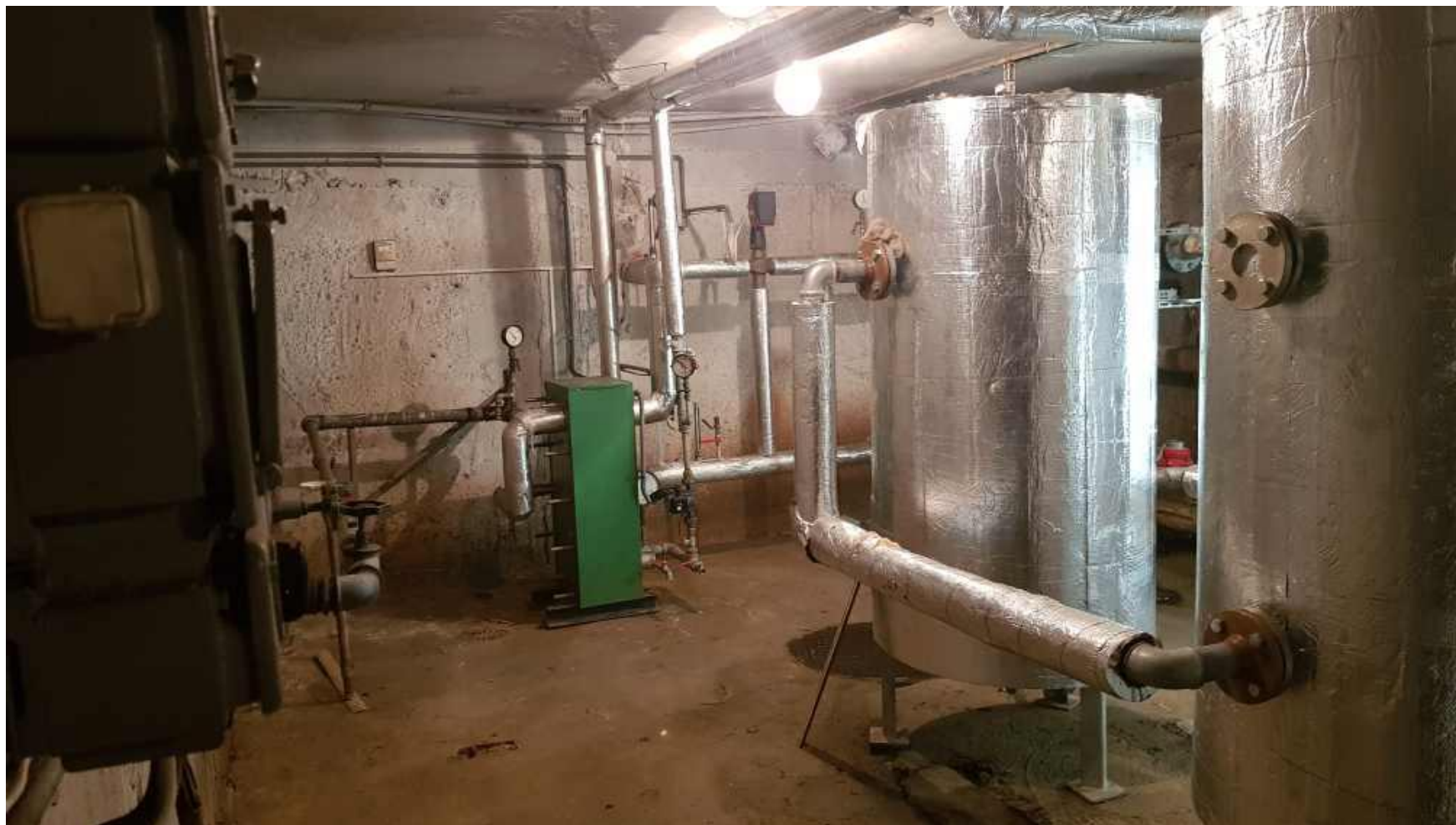
Pomieszczenie przyłącza CO i CW przed rewitalizacją
