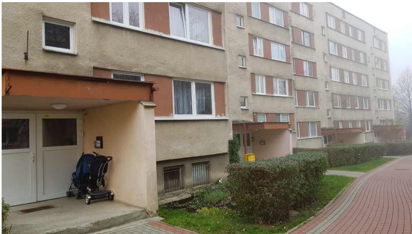
PRZYKŁADOWA ELEWACJA WSCHODNIA – BUDYNEK NR 25 – PRZED REWITALIZACJĄ
