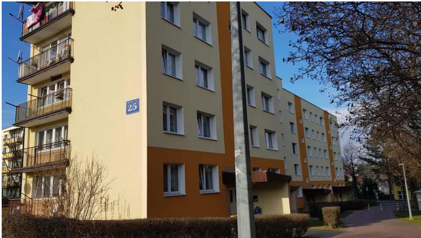
TA SAMA ELEWACJA – PO REWITALIZACJI
